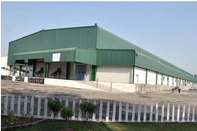
PAGRO plant at Fatehgarh Sahib (Punjab)
